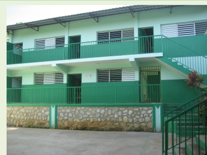
Der neue Anstrich der Schule
