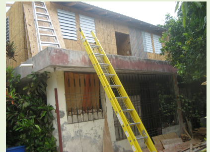
Die Aufstockung auf Annelieses Wohnhaus
