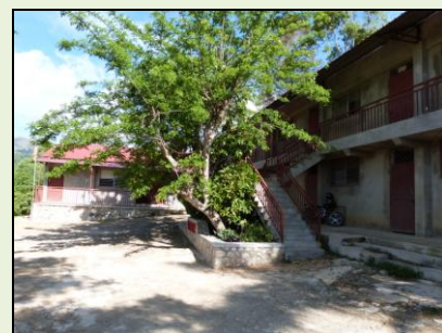
Obiges Schulgebäude nach dem Wiederaufbau mit Neubau im Hintergrund.
