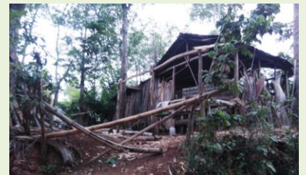
Sturmschäden im Umland
