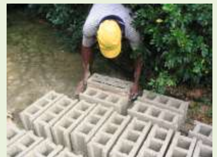
100% Handarbeit – die Steine für die Ziegel wurden per Hand zerkleinert, dann wurden die Ziegel geformt und getrocknet.
